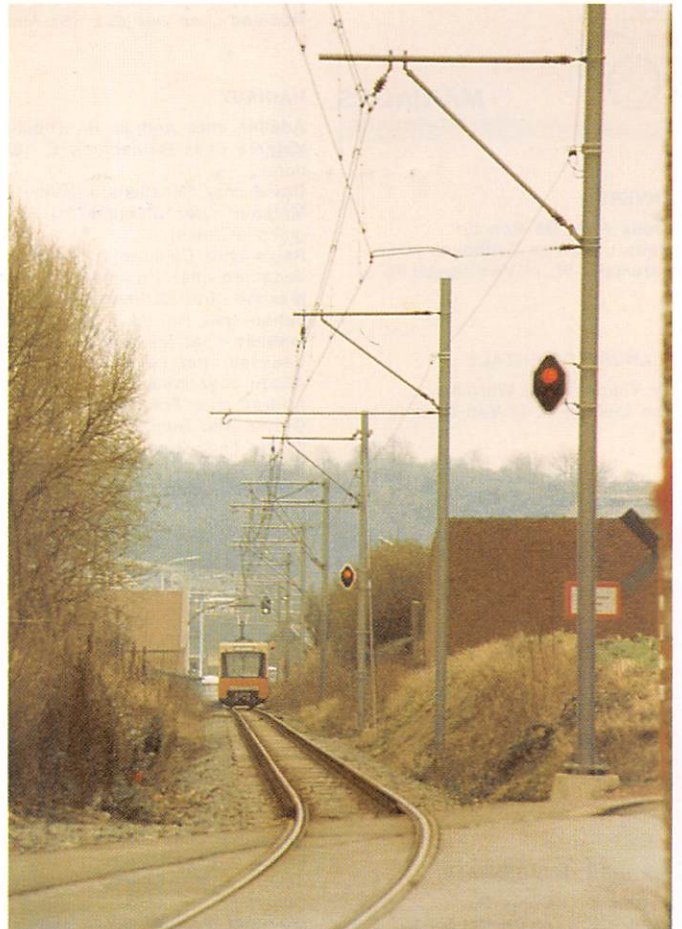
Simple voie équipée de poteaux latéraux à Anderlues (Groupe du Hainaut).
